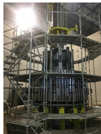
图5 转子测圆架和安装平台
